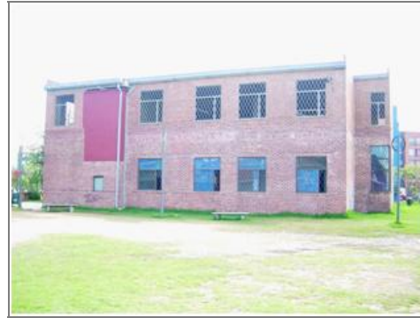
Salón Comunal Urbanización Cofradía. Foto: Convenio 140 de 2009
